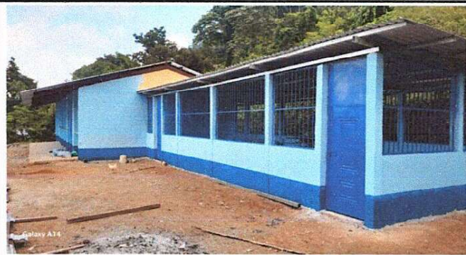
Foto1: Pintura remodelada, balcones y puertas colocadas
